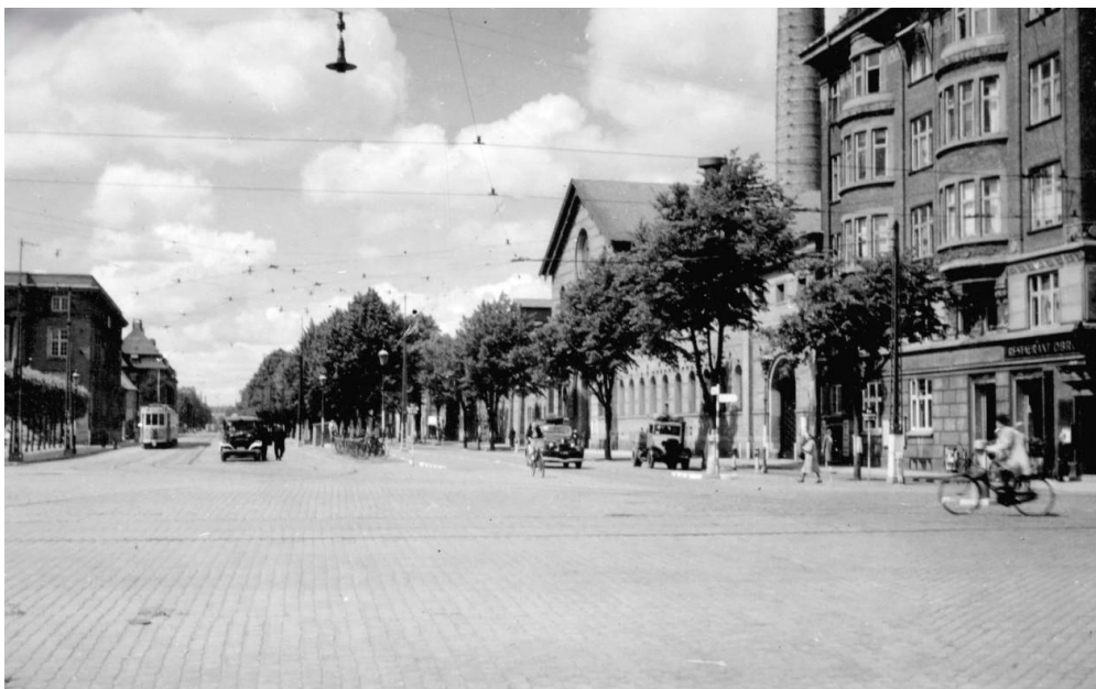
Øster Allé set fra Trianglen (eller familiens forretningsfacade) den 17. juni 1943, næsten uforandret til i dag (2025) omend der er asfalteret, plantet ny træer og sporvognenes ledningsnet forlængst nedtaget
