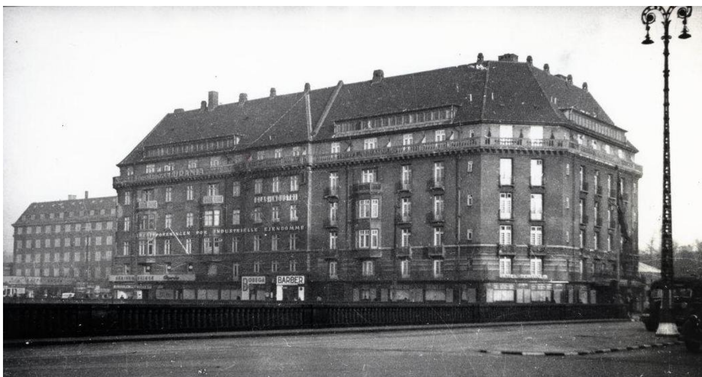
Panoptikon-bygningen (opr. bl.a. voksmuseum) efter at banegraven er anlagt i 1916, hvor ejendommen blev betydeligt ombygget. Den nedbrændte i januar 1950, hvor brandmuren dog reddede Hotel Terminus i højre halvdel for samme skæbne. 'Tea-Room' har formentlig ligget på 1. sal så nogenlunde ovenpå Bodegaen i gadeplan, altså med udsigt over mod Colbjørnsensgade. I baggrunden t.v., ses Axelborg og et enkelt vinduesfag af 'Olympia'-bygningen.
