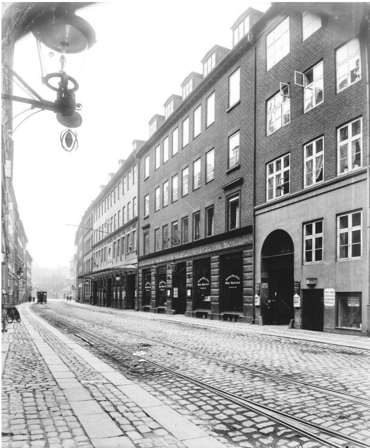
Rasmus Nielsens Auktionsforretning, Nørregade 41. Nielsen residerede her kun i få år, inden natklubben 'Adlon' i løbet af 1923 mere eller mindre tvungent blev installeret sammesteds. Bygningen undergik omfattende ændringer, hele baggårdsområdet blev inddraget og overdækket til dansegulv og lokalerne udsmykket i art deco-stil, og de overliggende etager (tidligere skole) blev omdannet til hoteldrift. Måske var dette sidste anledning til, at man fastslog etablisementets fornemme standard med navngivning à la det fashionable familiehôtel i Berlin, ejet af Lorenz Adlon. Læs mere om natklubben 'Adlon's storhedstid i 1920'erne under kommende indslag om Valdemar Eiberg.
