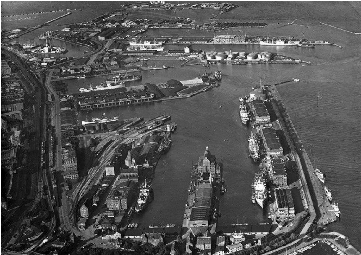
Til højre Langelinie kajen (udenfor Frihavnen), der ender i den lille fyrmole (hvilken i dag er nedrevet). Frihavns Amerikakaj (=Vestkaj) er den venstre kaj i det venstre midterbassin. Nederst i venstre hjørne ses Frihavns Toldkontrolbygning (med tårn) ved Folke Bernadottes Allé.
